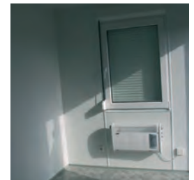
> Elektrische Gebläseheizung und Fenster mit Doppelverglasung + Roll-Läden
