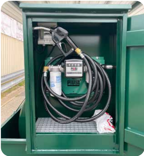
Schrank mit Auffangwanne und Gitterrost (ermöglicht das Auffangen von Lecks an der Pumpe und Pistole)
